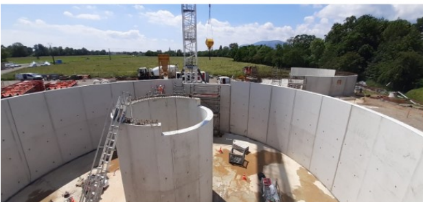
Le 4 juin : Bétonnage du bassin biologique et remplissage avec constat d'étanchéité. 3 quartiers sont coulés pour le clarificateur, le coffrage et ferrailage . Bassin d'orage : Ferrailage de la fosse d'arrivée .
