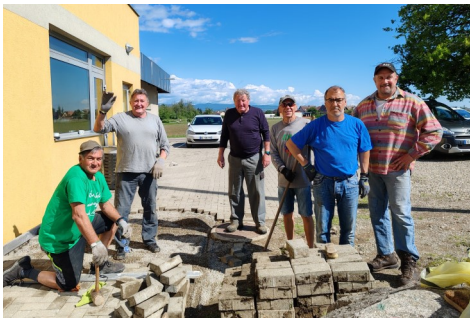
L'équipe de la pétanque pose des pavés devant les bâtiment « Chênes »
