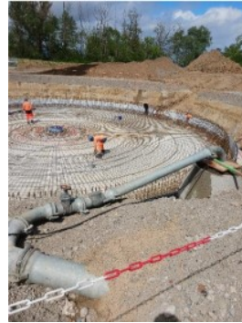
16 avril : Ferrailage radier du bassin biologique, radier fosse centrale du clarificateur, pose des conduites sous l'ouvrage, pré fouille et béton de propreté du bassin d'orage.
