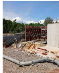
16 avril : Ferrailage radier du bassin biologique, radier fosse centrale du clarificateur, pose des conduites sous l'ouvrage, pré fouille et béton de propreté du bassin d'orage.
