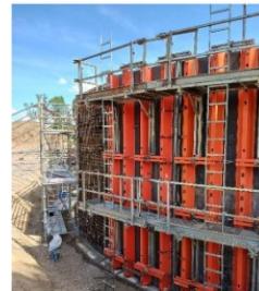
14 mai : Ferrailage de la seconde moitié du bassin et bétonnage du radier
