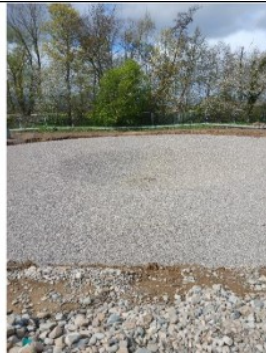
02 avril : Avancement : Béton de propreté mis en œuvre. Arase et fond de forme du clarificateur réalisés.
