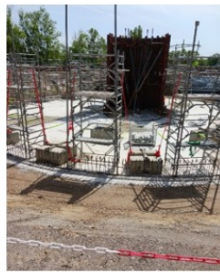
30 avril : Mise en place des coffrages du bassin biologique, réalisation du fût central du clarificateur ainsi que la pose des conduites et le ferrailage en radier.
