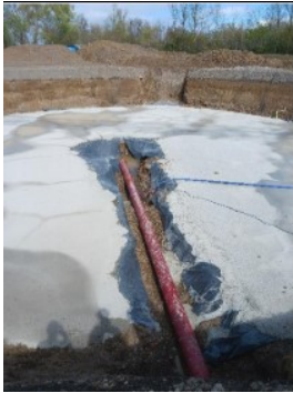
02 avril : Avancement : Béton de propreté mis en œuvre. Arase et fond de forme du clarificateur réalisés.
