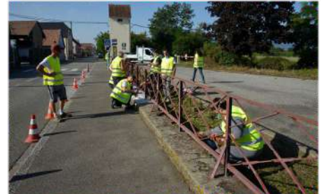
Atelier peinture garde-corps Bains
